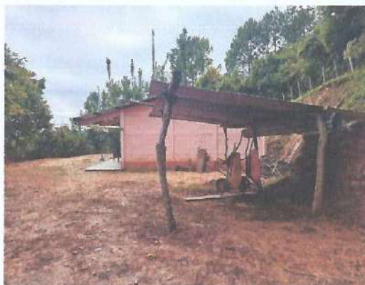
Foto 2: Mejoramiento de losa de piso de la cocina
