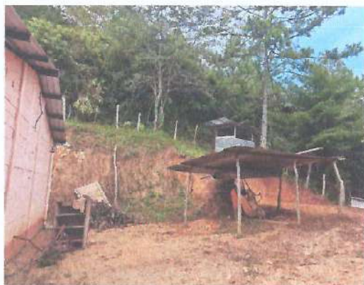
Foto 1: Mejoramiento con estructura tipo pórtico e instalación de lámina troquelada calibre 26 de la cocina
